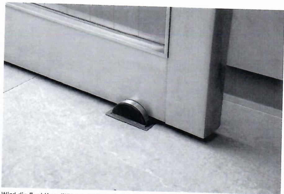
Wird die Funktionalität von Schutzeinrichtungen aktiv, z. B. durch Türkeile, verhindert, gilt dies als Straftat.
