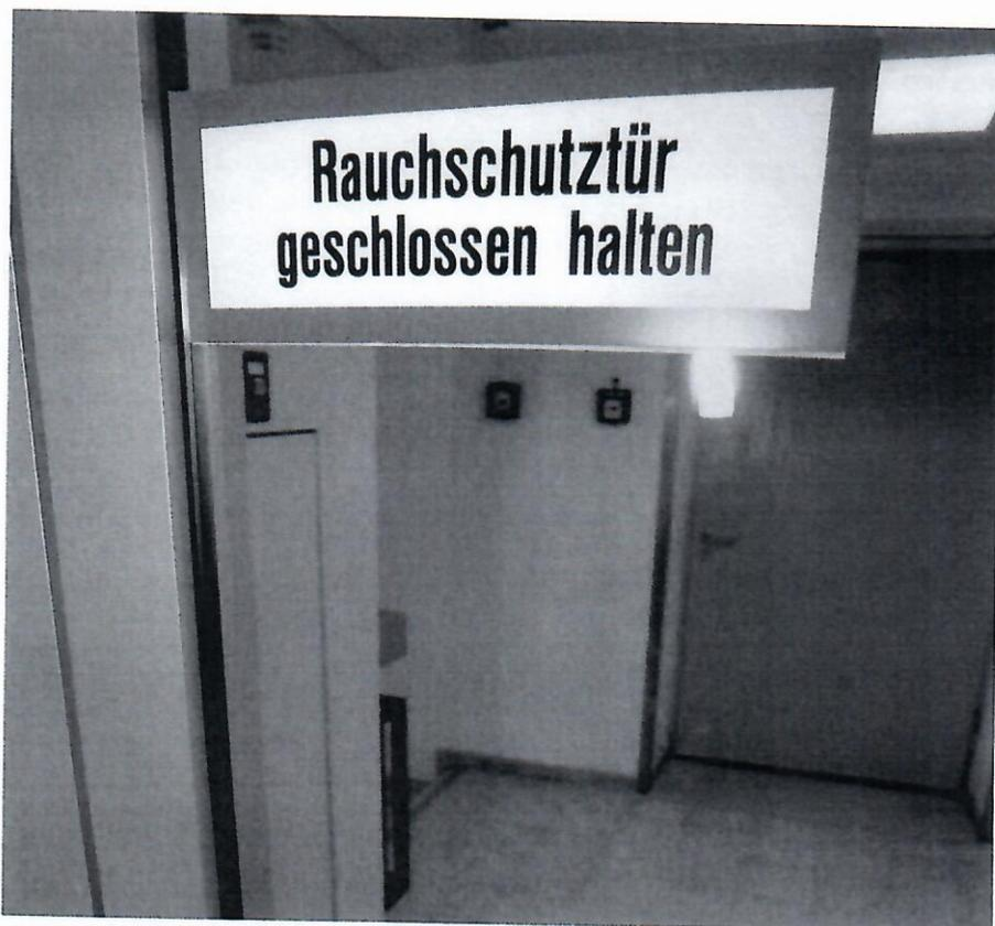
Selbstschließende Türen sind dazu bestimmt, den Durchtritt eines Feuers durch Öffnungen in Wänden oder Decken zu verhindern.
