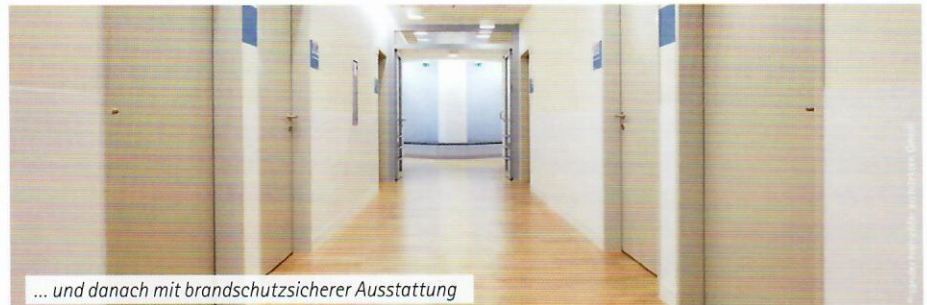
Flur in der Pflegestation der CRONA-Kliniken vor der Sanierung ...
