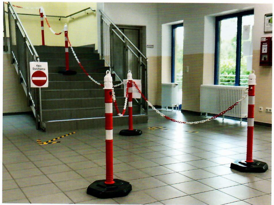
Flucht- und Rettungswege sind hier durch Stolperfallen eingengt.
