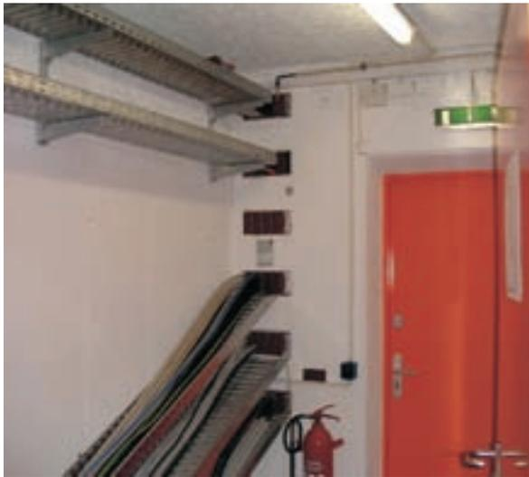
**Bild 4.01:** Kabelschottung
